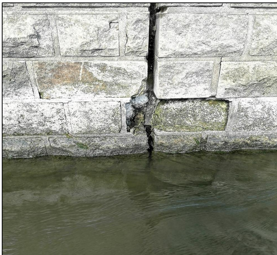
Foto č. 4 – Poškozená dilatační spára tělesa rybího přechodu na VD Terezín
