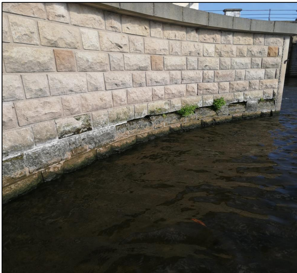
Foto č. 2 – Poškozený pískovcový obklad tělesa rybího přechodu na VD Terezín
